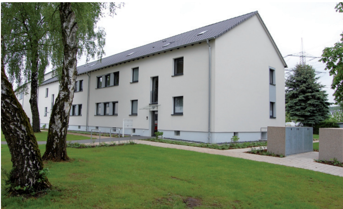
Eingang nach der Modernisierung
