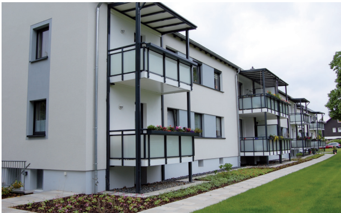
Rückseite nach der Modernisierung
