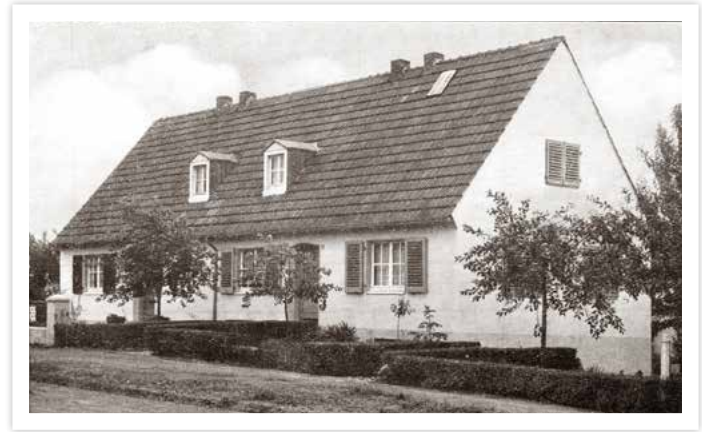
Doppelhaus der 2. Siedlung Deller Straße
