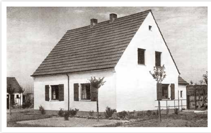
Doppelhaus der 1. Siedlung Deller Straße
