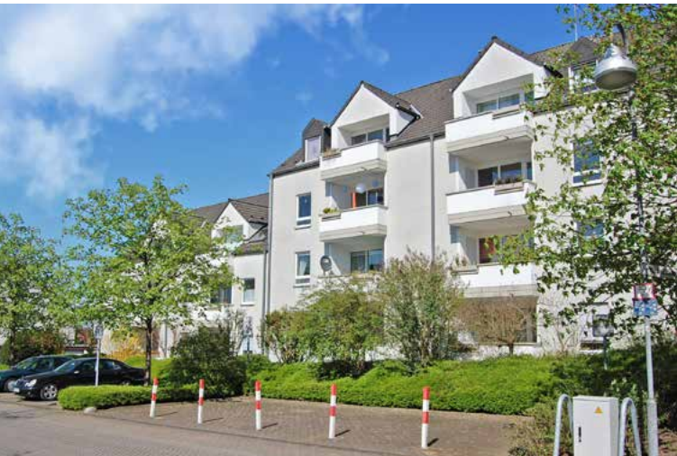
Seilbahnweg 6 – 10 in Haan-Gruiten
