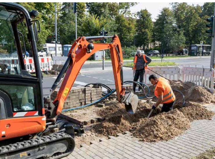
Tiefbauarbeiten und Kabelverlegung zu den Gebäuden
