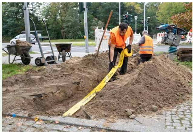
Tiefbauarbeiten und Kabelverlegung zu den Gebäuden
